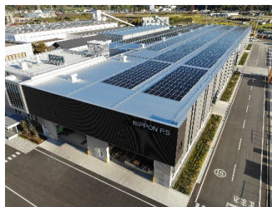
太陽光パネル
