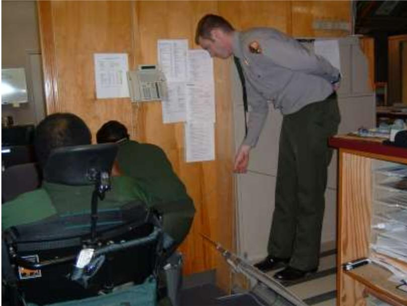
チケットカウンター裏のリフト。約20cmほどの段差を解消するために設置されている。
