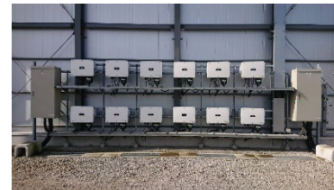
パワーコンディショナー・集電盤
