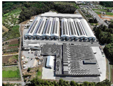
太陽光パネル
