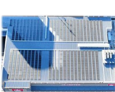
太陽光パネル
