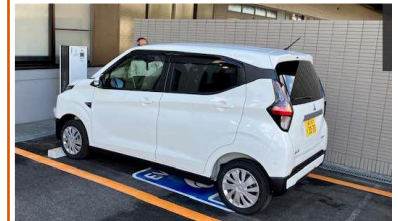
車載型蓄電池/充放電設備
