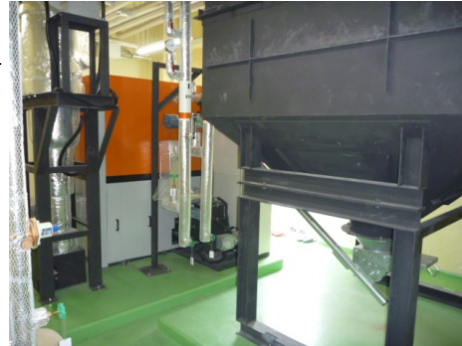
ペレット ボイラー
