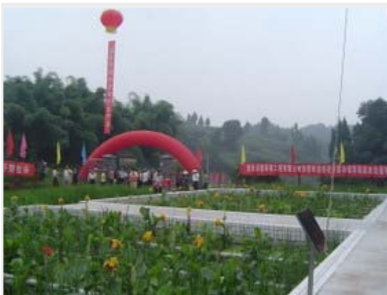
手前の花壇のように見えるのは人工湿地。ここで汚染物質を半減させる
